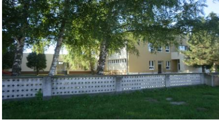
(Budova materských škôl)
